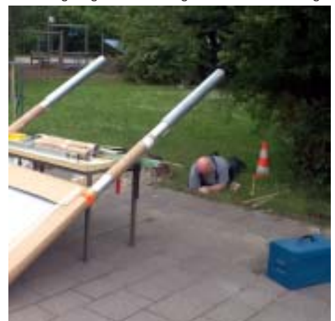
Für tiefgründige Arbeiten stets zu haben: Herr Neumann schafft das Fundament für den Infoschaukasten.
